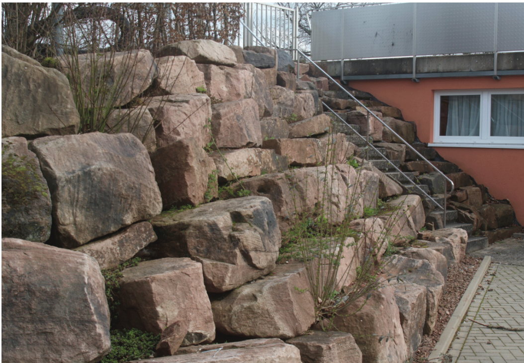
Abb. 3: Trockenmauer im Osten des UR
